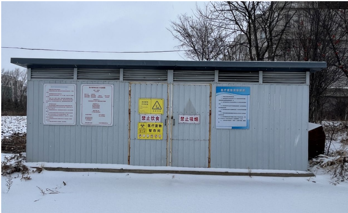
医疗废物暂存间
